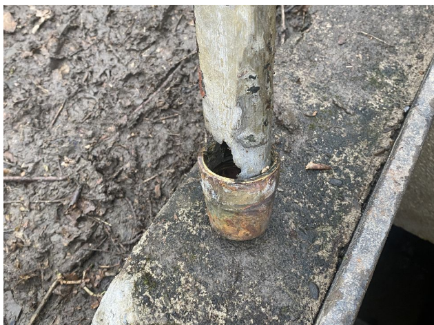
Silně zkorodovaný uzávěr odkalovací jímky - veškerá jímaná voda odtéká odpadním potrubím nikoliv do vodojemu
