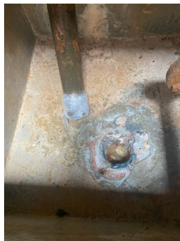
Silně zkorodovaný uzávěr odkalovací jímky - veškerá jímaná voda odtéká odpadním potrubím nikoliv do vodojemu
